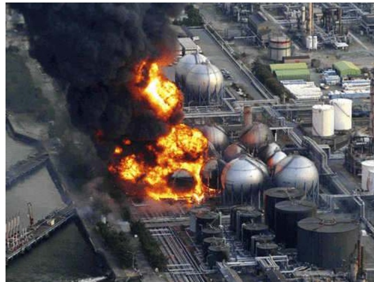
Aspecto da central de Fukushima após o maremoto ocorrido em 11 de Março de 2011. Imagem extraída da Internet.
